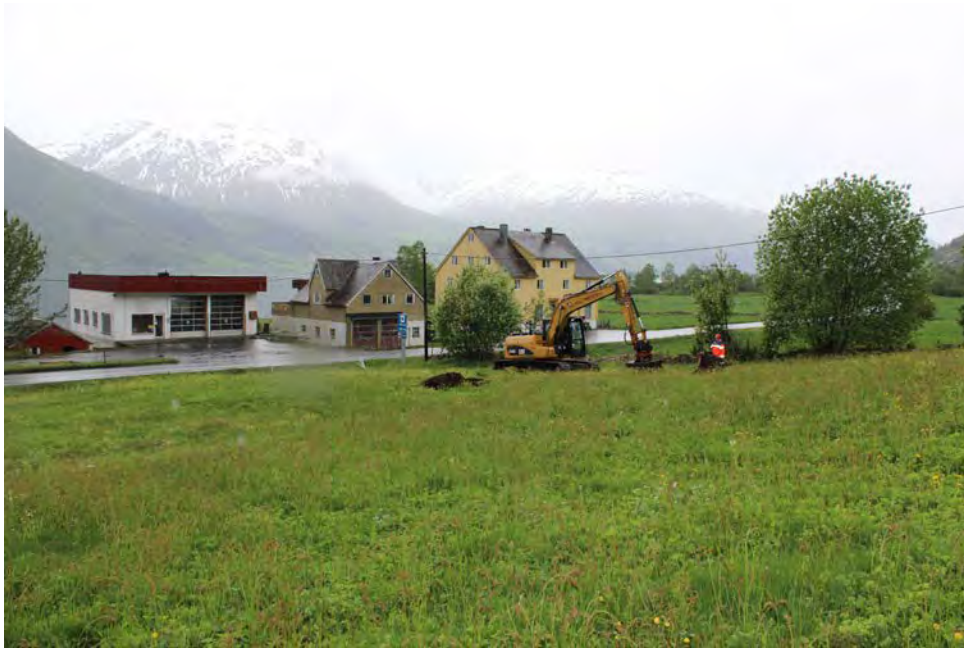
Figur 64 Oversyn over lok. 10 under avdekking. I bakgrunnen t.h. er elveflata med lok. 8 og 25 synleg. Sett mot S. Foto: CFK.
