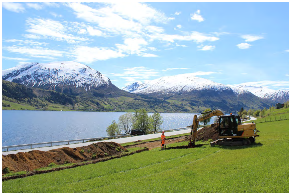
Figur 20 Oversyn over lokalitet 5 under avdekking. Sett mot SV. Foto: CFK. Avbildat: CEM.
