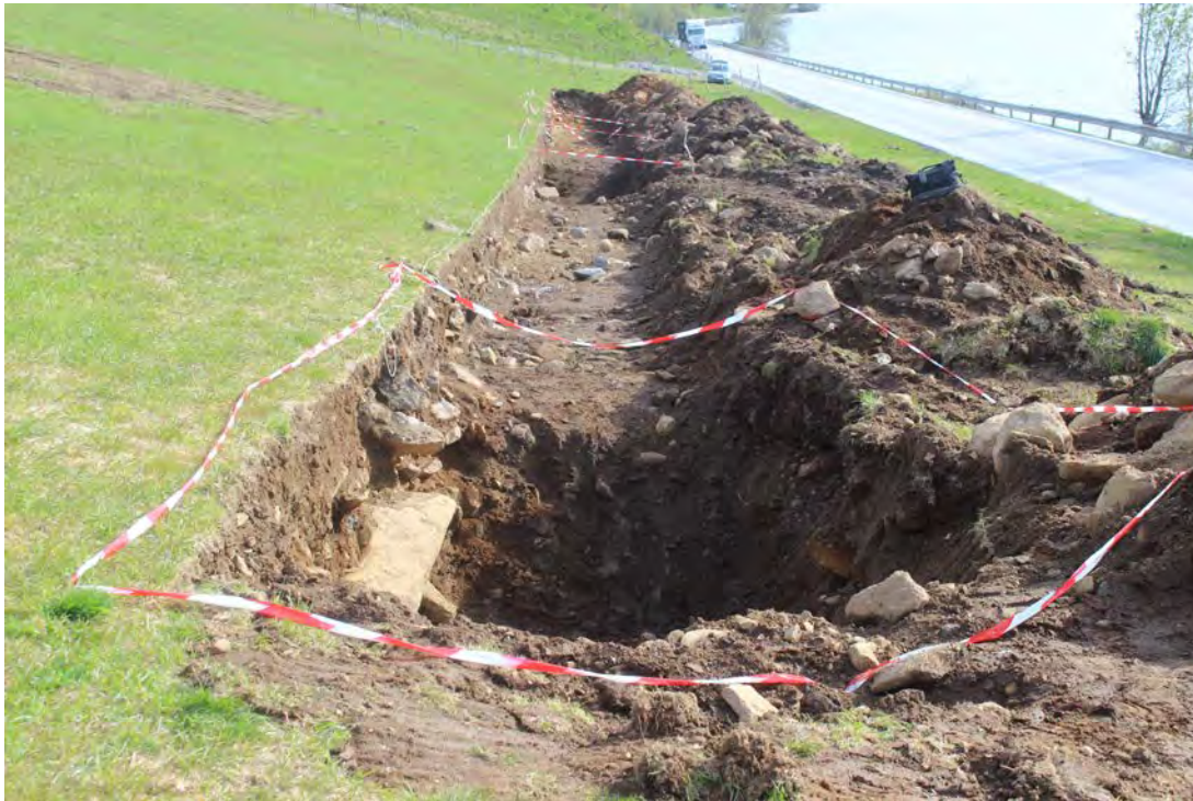
Figur 12 Oversyn over Lok. 2. Sett mot NA. Foto: ABO.
